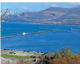
小樽港北防波堤
